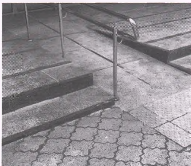
Фото №2. Пандус до до будівлі
