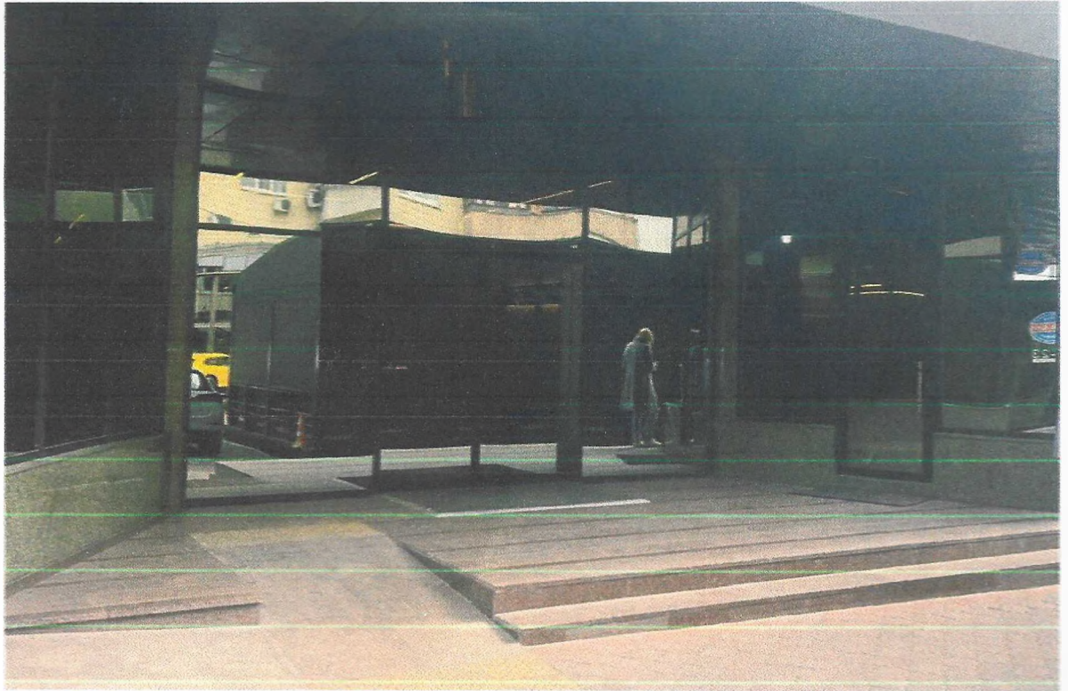
Фото №1. Вхідна група до адміністративної будівлі
